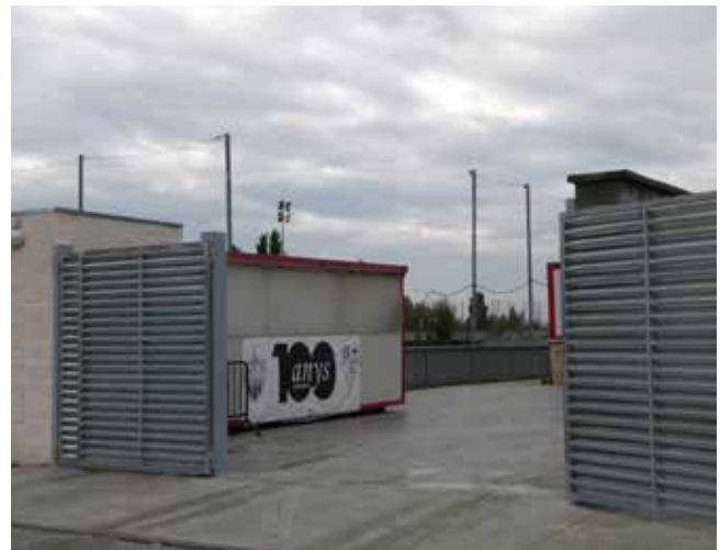
El camp de futbol municipal disposa d'una nova entrada i nous mòduls de serveis
